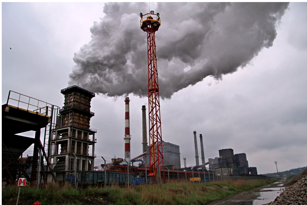
Koksownia Częstochowa Nowa z pracującą wieżą gaszenia koksu
